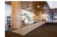
スロープの設置
